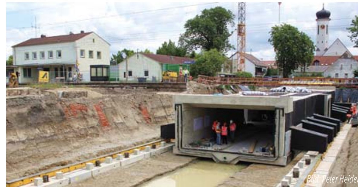
Juni 2019: Die neue Röhre ist an ihrem Platz. Sie wird künftig einen barrierefreien Durchgang sowie Zugang zu den Gleisen ermöglichen. Außerdem schafft sie eine bequeme Querung unter der Bahnlinie für alle Fußgänger und Radler.
